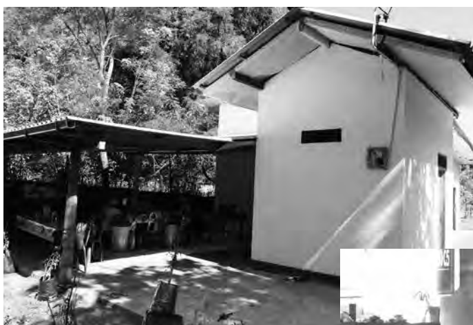
マーケティング・センターの外観(写真6)
